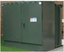
Mise à la terre haute impédance
